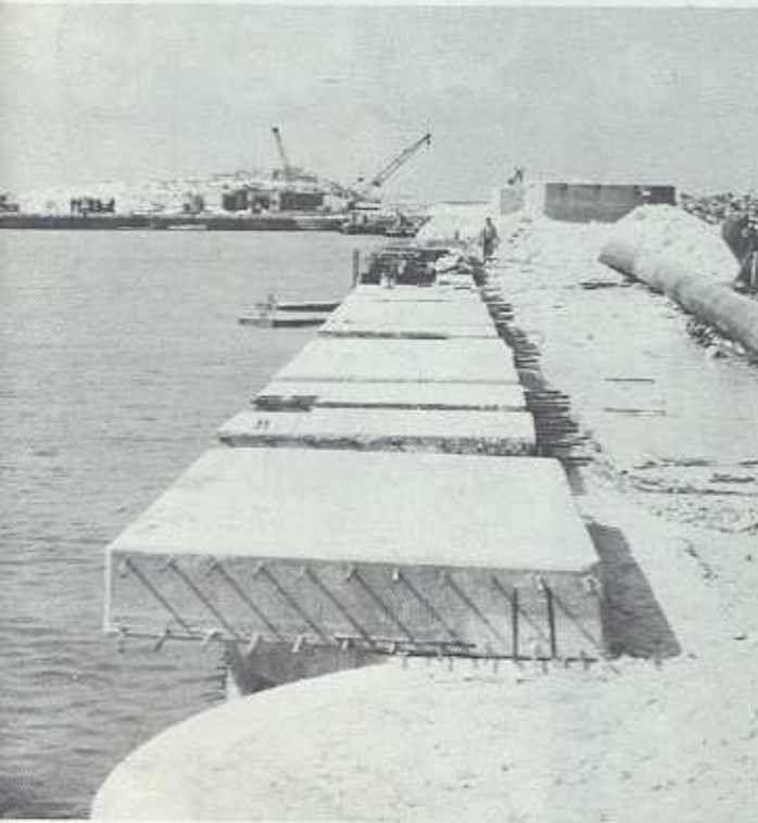
ميناء بريقة في طريق الانشاء .
