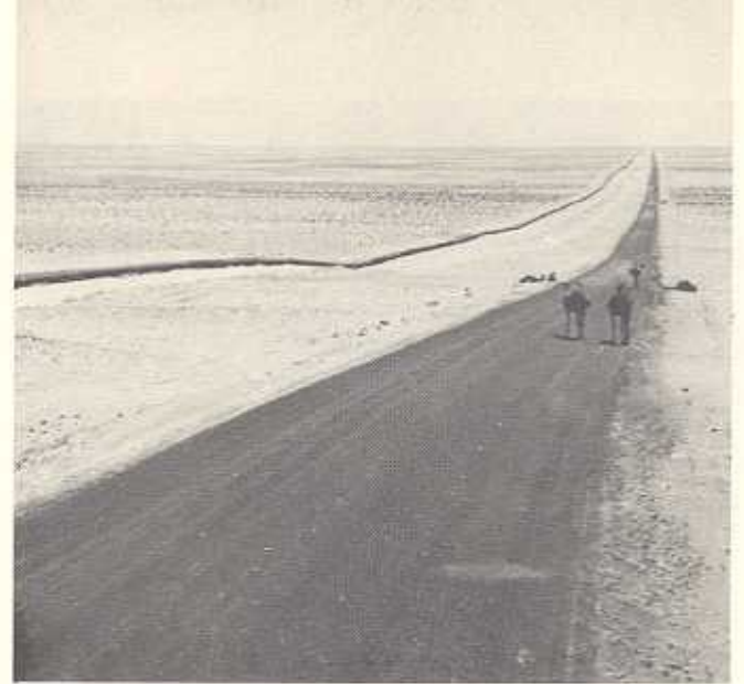
البوب الزيت ( الى اليسار ) وطوله ١١٠ اميال وقطره ٣٠ الفاً ويجري فيه الزيت من زلطن الى مرسى بريقة على خليج سرت . وقد بنت شركة اسو طريقاً معاذية للانبوب
